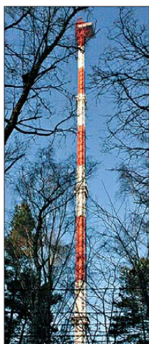
Bild 4: Der 358 m hohe und 920 t schwere Richtfunkmast in Berlin-Fohnau
