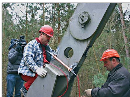
Bild 6: Montage einer Sprengladung an einem der Pardunenfundamente des Mastes
