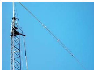
Monoband-Rotary-Dipol CX 40 RD Elementhälfte mit Linearelement
